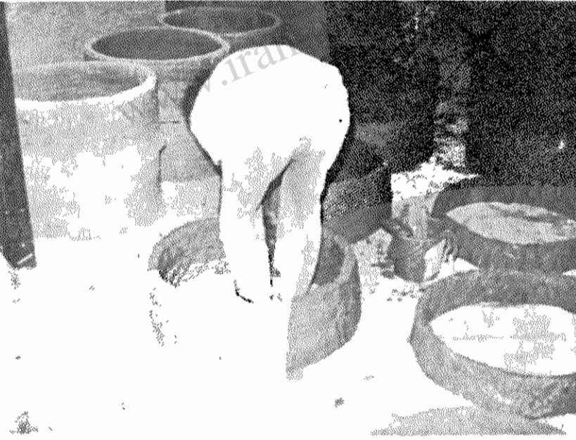
کارگاه گومسازی - کارگر در حال ساختن گوم
