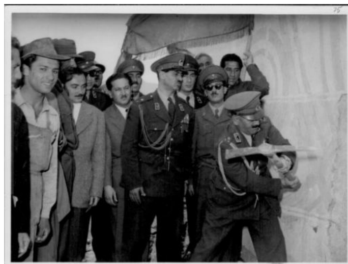
تیمسار باتمانقلیچ در حال تخریب گنبد ساختمان حظیرةالقدس تهران - اردیبهشت ۱۳۳۴
